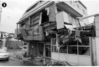
①この地域では、竹を縄で縫った木舞(小舞)を柱と梁の間に入れ下地を作り、土を塗り、しっくいにて仕上げた土壁の住宅も多い。筋交いはなく、地震の揺れに対しては弱い。②1階部分が座屈した住宅③全壊となった商店
