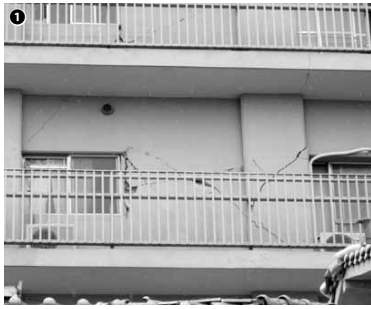
①5階部分の柱脚が損壊し、全壊となったマンション。②傾斜して解体が始まったビル
