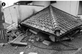
①この地域では、竹を縄で縫った木舞(小舞)を柱と梁の間に入れ下地を作り、土を塗り、しっくいにて仕上げた土壁の住宅も多い。筋交いはなく、地震の揺れに対しては弱い。②1階部分が座屈した住宅③全壊となった商店
