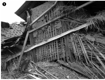
①この地域では、竹を縄で縫った木舞(小舞)を柱と梁の間に入れ下地を作り、土を塗り、しっくいにて仕上げた土壁の住宅も多い。筋交いはなく、地震の揺れに対しては弱い。②1階部分が座屈した住宅③全壊となった商店
